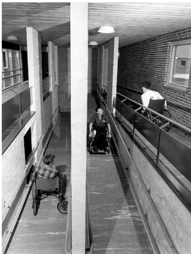
Rampen ned til kælderen har gennem årene været brugt til mange formål: racerbane, spøgelsestunnel og stævnemøder. I dag er den erstattet af en elevator.
