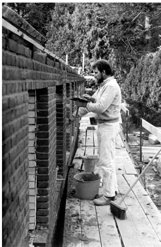
Murerne er i gang med at bygge "Orange gang".
